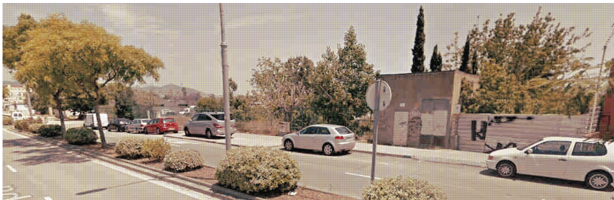
Estació transformadora elèctrica
